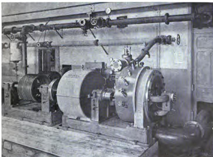
FIG. 113.—300 B.H.P. “ DE LAVAL ” STEAM TURBINE MOTOR.
