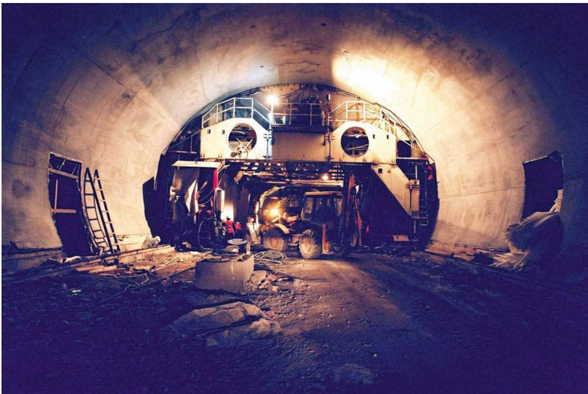
Fig. 6.70 Veliki Gložac Tunnel
