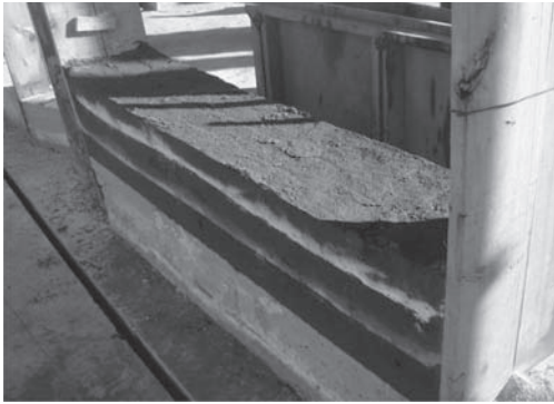
Figura 12. Juntas constructivas coloreadas con ferrita.
