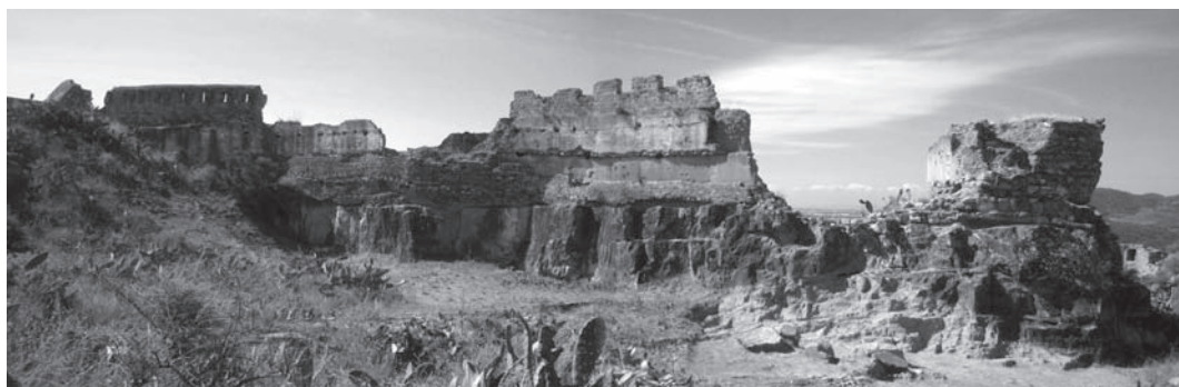
Figure 3. Estado previo. Alzado norte, interior, del sector 3.
