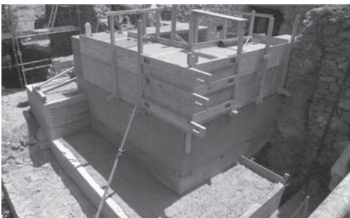
Figura 5. Levantando la última hilada de la torre original de tapia con los dos restantes muros a distintos niveles.
