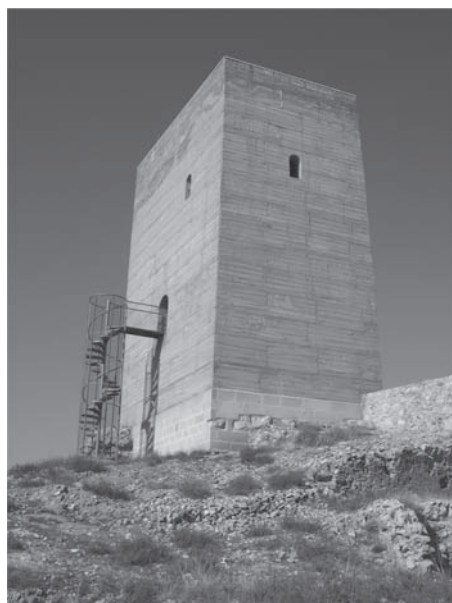
Figura 16. Torreón de tapia de yeso restaurado.
