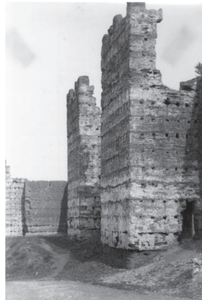
Figure 4. Fortified walls of Ceuta (1967) Fuente: Ministerio de Cultura. Archivo General de la Administración. Fondo Cultura, IDD (03)116, Caja 26/113.
