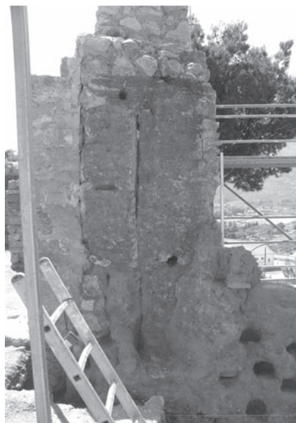
Figura 3. Las dos hojas en el entronque con la torre de tapia.
