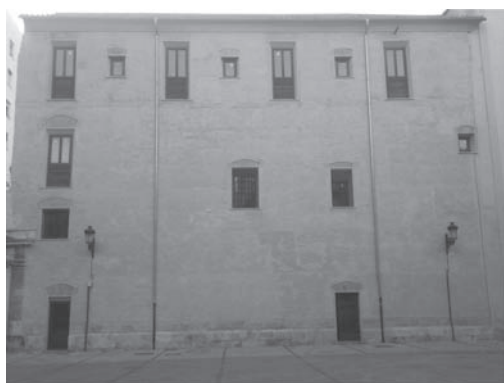
Figura 7. Capilla del Rosario. Iglesia del Pilar, Valencia. Restauración mediante la consolidación de las distintas fábricas.
