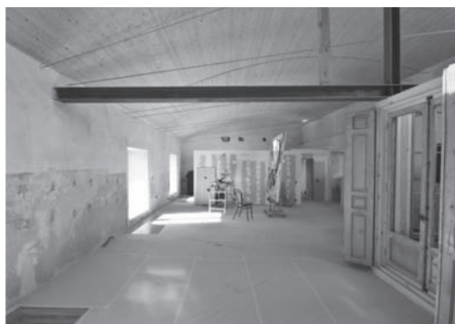
Figura 12. Interior de la planta primera. (Autor: J. Muñoz).
