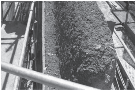
Figura 17. Consolidación como ruina de coronación de muro.
