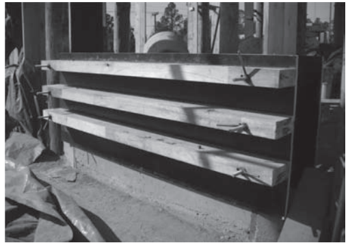
Figura 10. Encofrados utilizados en muros.
