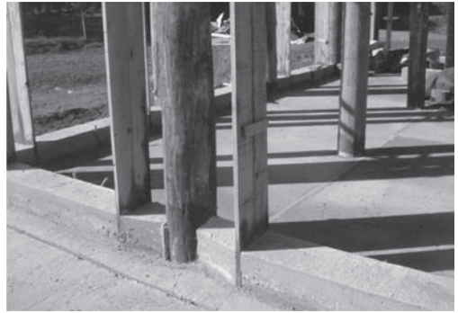
Figura 9. Pies derechos y encofrados.
