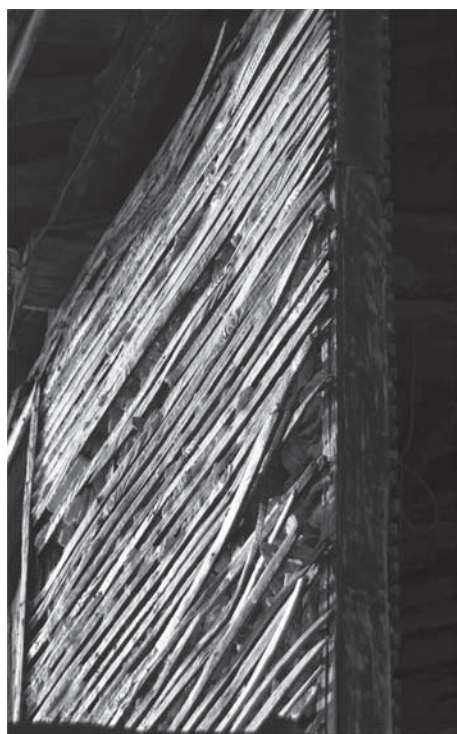
Figura 4. Pared exterior gallega de palla-barro.
