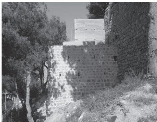
Figura 9. Vista oeste de la torre norte al finalizar los trabajos. Compárese esta imagen con la de la figura 1.
