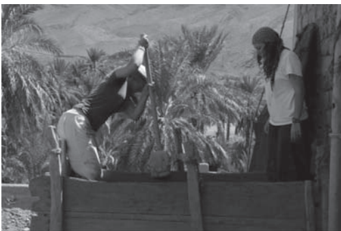
Figura 1. Apisonado de tierra.
