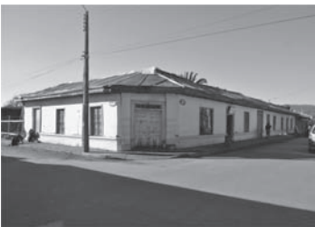
Figure 2. The ochavo , oblique corner wall (Jorquera N., 2011).
