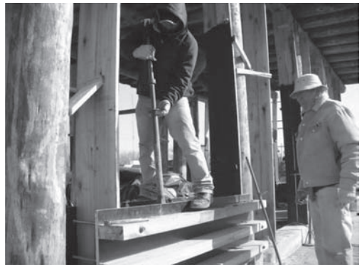
Figura 11. Pisón metálico.
