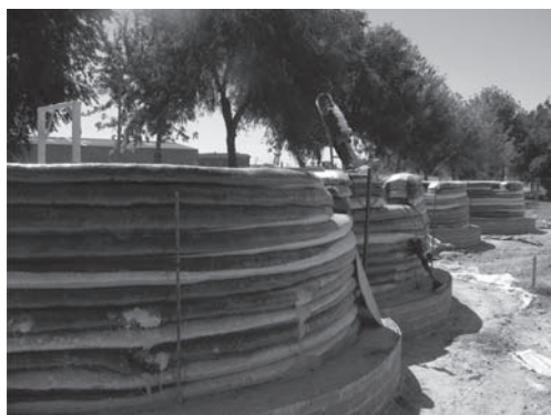
Figura 5. Proceso de construcción. (Autor: P. Diez Rodríguez).
