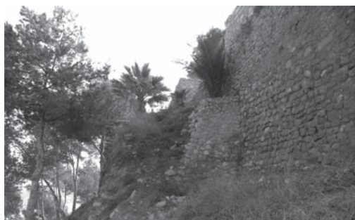
Figura 1. Vista oeste de la torre norte antes de la intervención.
