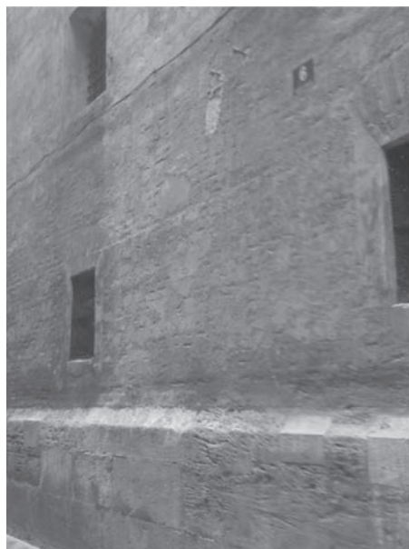
Figura 2. Colegio Corpus Christi de Valencia. Potente zócalo de sillería.
