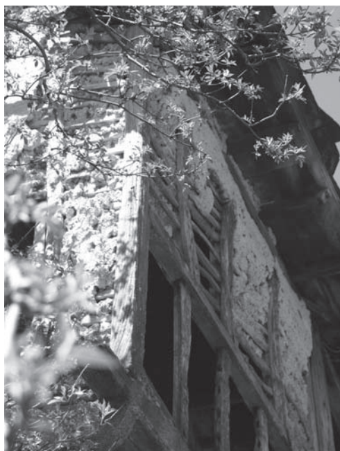
Figura 5. Pared exterior de varillas y trenzas de centeno revocadas en El Bierzo.
