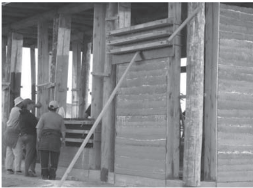
Figura 13. Vista general de obra en construcción.
