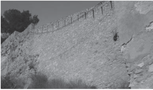
Figura 10. Vista frontal del tramo intervenido.
