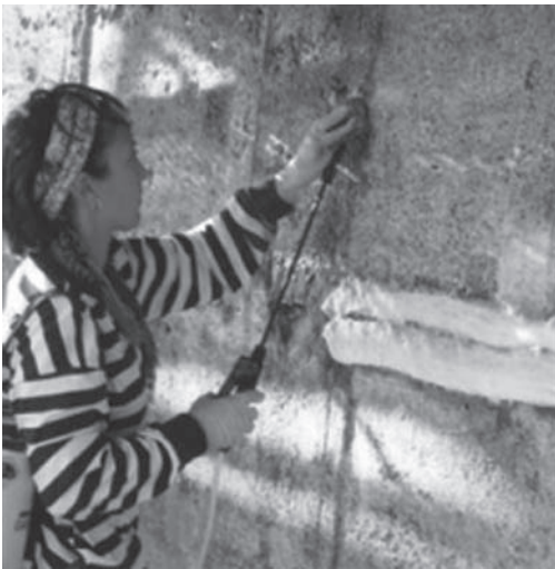
Figura 4. Limpieza de tapial calicostrado.
