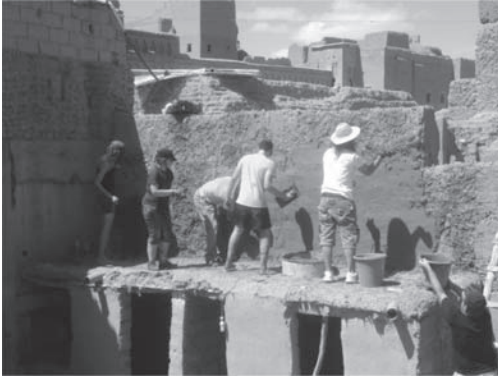
Figura 3. Ejecución de revoco.
