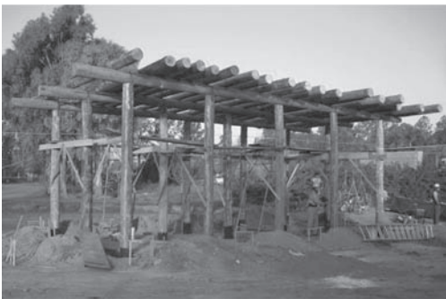
Figura 8. Entramado de madera.
