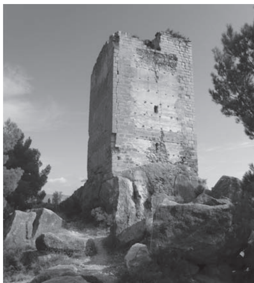
Figura 7. Vista de la fachada sur. Se aprecia la técnica mixta de tapia y sillares reforzando las esquinas.
