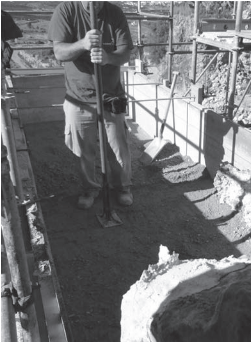
Figure 8. Compactación manual de la nueva fábrica de tapial.
