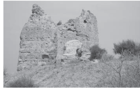
Figure 11. Rammed earth tower in Tènès. (Alliche. S., 2011).
