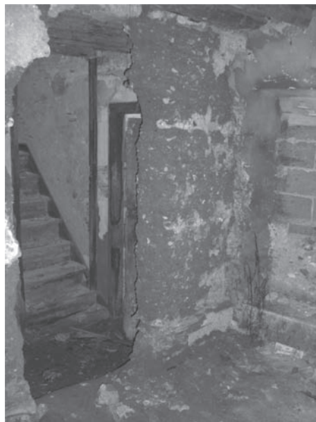
Figura 5. Vestigios de muros de tapia en el barrio de la Mouraria en Lisboa, con granulometría semejante a la muralla Fernandina de tapia. Imagen de 2010.
