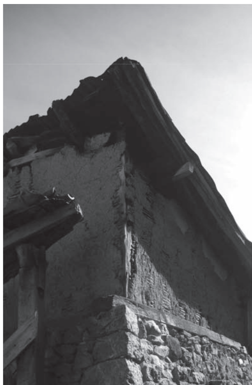
Figura 1. Encestado revocado en Cantabria.
