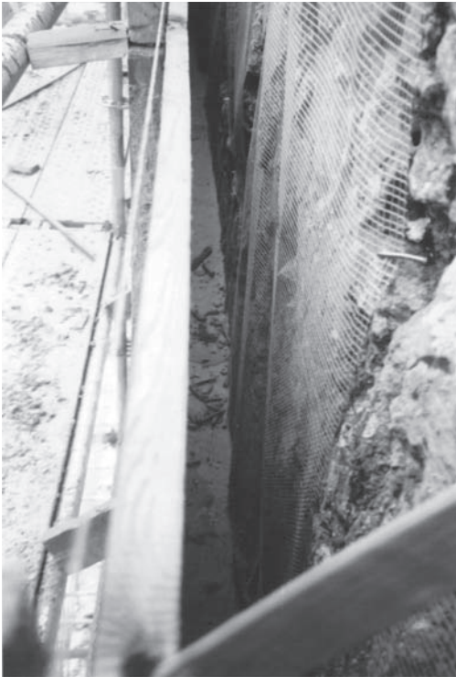
Figura 10. Malla de fibra de vidrio y tapia de yeso nueva.
