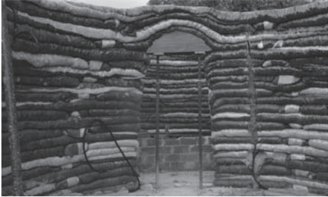
Figura 8. Colocación de cimbras para huecos de paso. (Autor: P. Diez Rodríguez).
