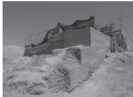
Figura 10. Tapia regularizada con fibras en la calicostra.
