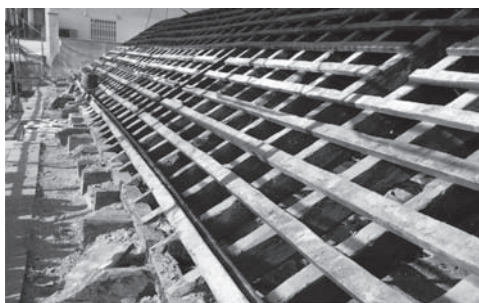
Figura 3. Capilla del Rosario. Iglesia del Pilar, Valencia. Coronación del muro de fachada con rafe independiente, sin albardilla de sellado.
