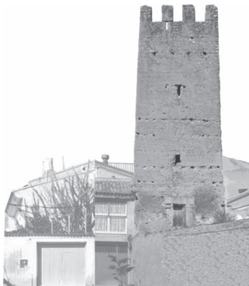
Figura 2. Alzado este. En esta fachada se encuentran la puerta de acceso original en primera planta, las aspilleras en segunda y tercera altura y las almenas rematando la torre. (Autor: realización propia).
