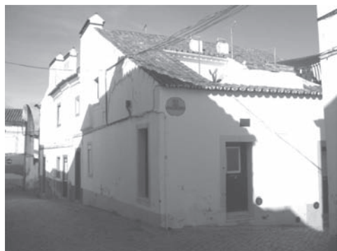
Figura 6. Casas de tapia, rehabilitadas y mantenidas en el centro histórico de Évora en el año 1982–1983, Mouraria . Imagen de 2006.
