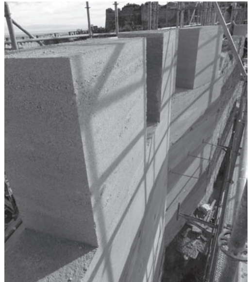
Figure 9. Agujas de madera y varillas roscadas necesarias para apretar los costales de las tapialeras.
