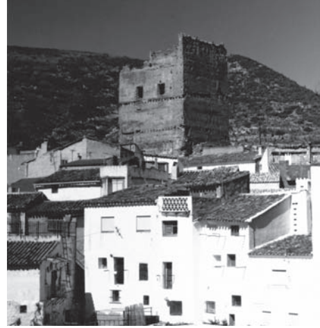
Figura 1. Vista de la Torre del Castillo de Sot de Chera antes de su restauración (año 2002).
