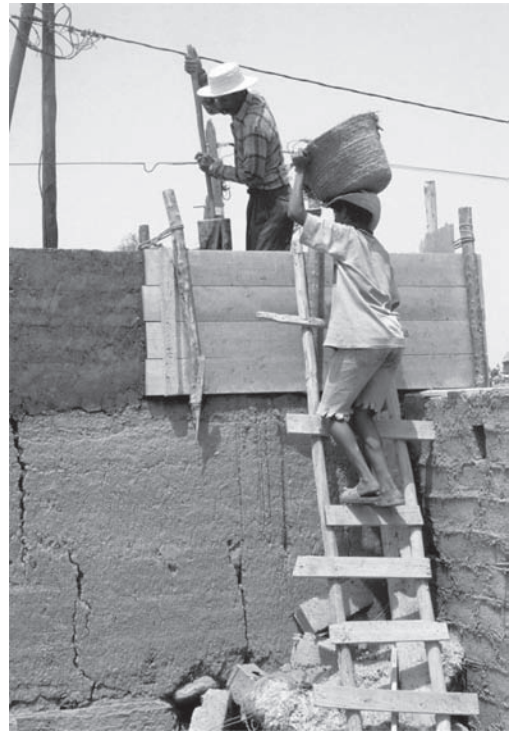
Figura 5. Técnica del Tapial.
