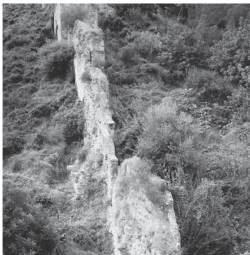
Figura 3. Tramo E11 de las murallas de levante antes de la intervención.
