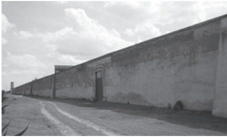
Figura 10. Fachada posterior de la casa grande de la hacienda. Imagen de autor.
