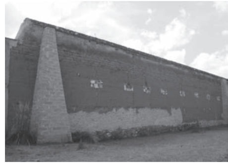
Figura 4. Muro de tapia en la fachada norte de la fachada de la casa grande. Imagen de autor.
