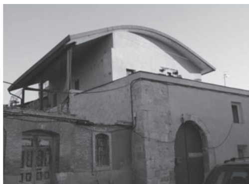
Figura 11. Fachada lateral al patio. (Autor: M. Macho).
