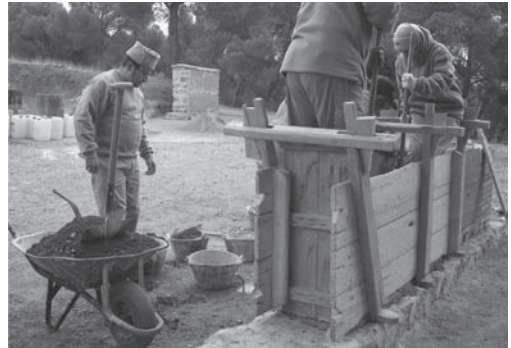
Figura 7. Fabricación de tapia de pequeño espesor.
