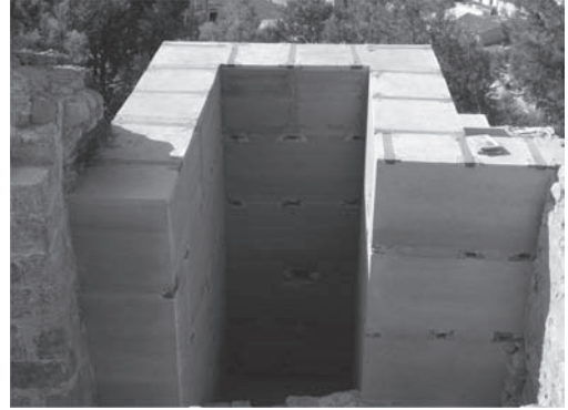
Figura 7. Obsérvense las maderas en el remate en la torre terminada. Compárese esta imagen con la de la figura 4.
