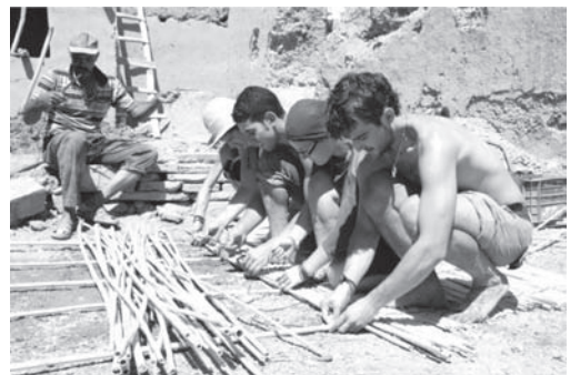
Figura 2. Ejecución del cañizo.
