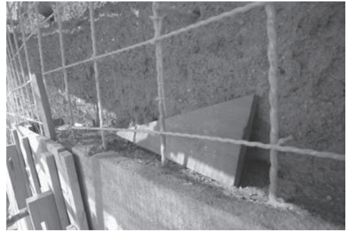
Figura 13. Tapia de cal con mallazo de fibra de vidrio.
