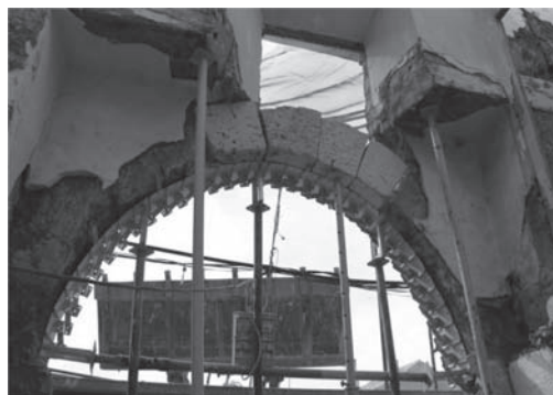
Figura 9. Restauración del arco de entrada. (Autor: P. Díez).
