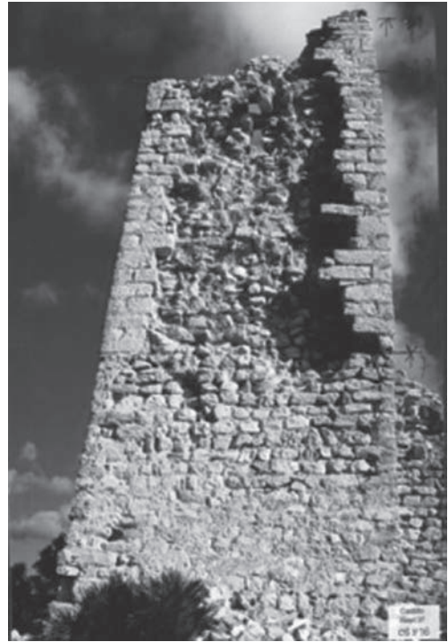
Figura 1. Paramento oeste de la torre. Muro de mampostería encofrada reforzada en las esquinas por piedras careadas de mayor tamaño.
