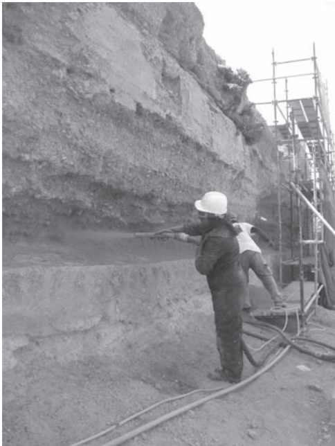
Figura 3. Tierra proyectada para colmatación de lagunas en las murallas del castillo de Paderne, en Albufeira. 2005.
