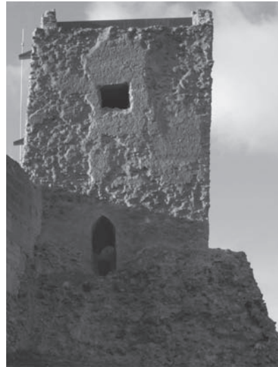
Figura 18. Consolidación de muro de tapia de piedra.
