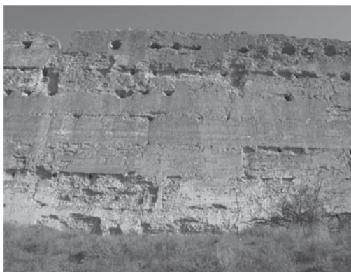
Figura 4. Muro mejor conservado con agujas pasantes.
