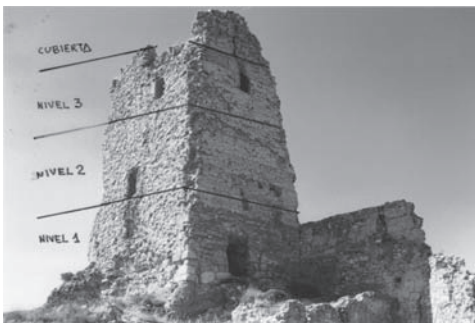
Figura 5. Torreón de tapia de yeso.
