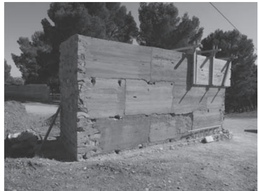
Figura 8. Fabricación de tapia del espesor de la muralla.
