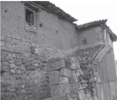
Figura 3. Fachada lateral al patio. (Autor: M. Macho).
