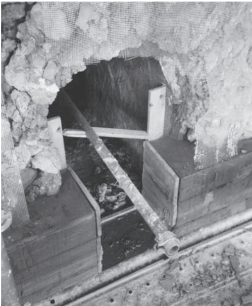
Figura 11. Vano en proceso de restauración con volumen importante de tapia a reponer.
