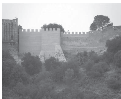
Figura 6. Tramo S4 de las murallas del patio de armas después de la intervención.
