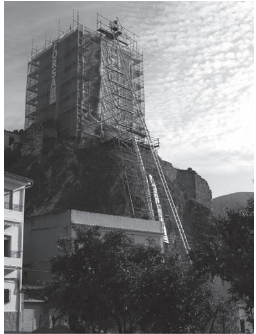
Figura 3. Vista del andamio y del montacargas en el inicio de las obras.
