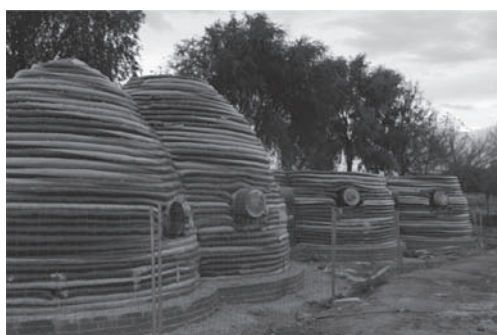
Figura 6. Proceso de construcción. (Autor: P. Diez Rodríguez).
