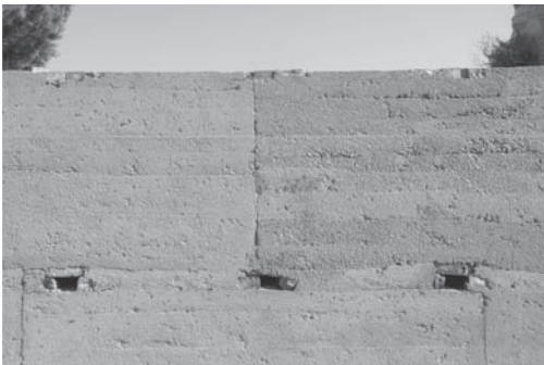
Figura 6. Paramento calicostrado cepillado con los mampuestos vistos y las marcas verticales de las tapiadas.
