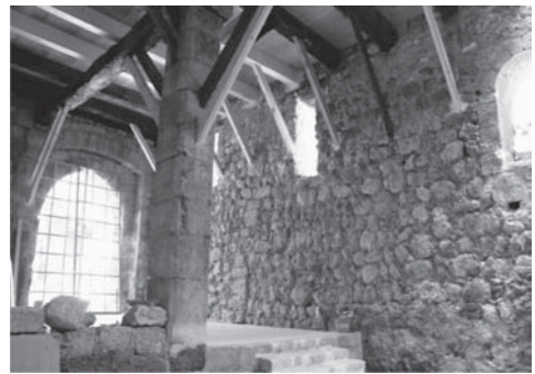
Figura 7. Arcos de acceso. Interior. (Autor: M. Macho).
