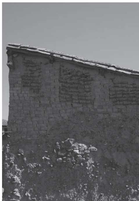
Figura 7. Tepes de turba sobre muro de tierra en el Valle de Vidriales.
