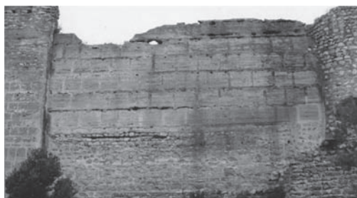
Figura 3. Muro de tapial calicostrado, decorado con sillería fingida, que se eleva sobre un zócalo de mampostería encofrada asentada directamente sobre la roca.
