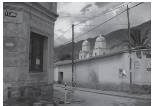
Figura 3. Vista de la Iglesia de Tilcara, Jujuy.
