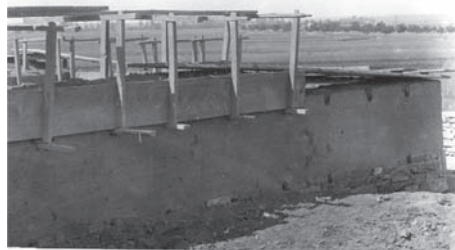
Figure 1. Rammed earth construction in Hroznová Lhota, distr. Hodonín, in 1910 (Karel Chotek).
