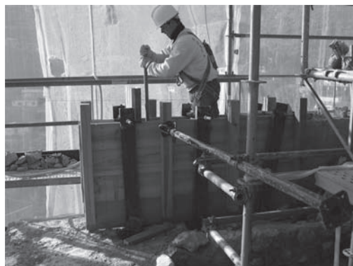
Figura 4. Compactación de la masa de la tapia.
