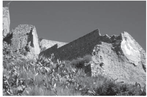
Figure 2. Estado previo. Alzados exteriores del sector 2.
