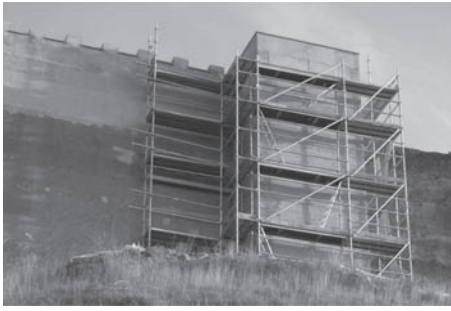
Figura 16. Muro de hormigón de cal con calicostra.
