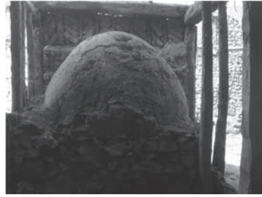
Figura 1. Cedillo de la Torre (Segovia), horno de adobe semiesférico.
