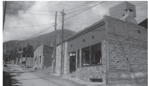
Figura 7. La nueva construcción con estructura de hormigón armado.
