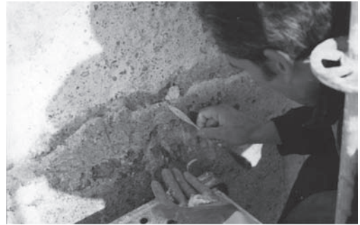
Figura 5. Sellado de sillares fingidos.
