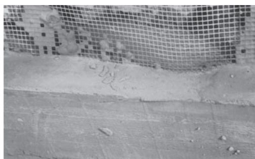
Figura 9. Malla de fibra de vidrio y tapia de yeso nueva.
