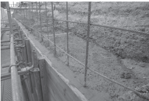
Figura 12. Tapia de cal con mallazo de acero inoxidable.
