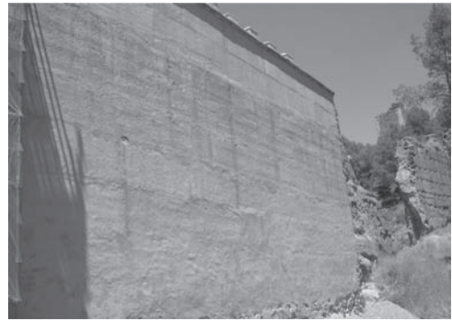
Figura 14. Pruebas cromáticas del hormigón de cal.
