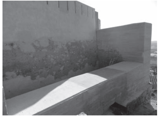
Figure 7. Alzados exteriores del sector 2. Cambio de materialidad en la zona que conecta los dos muros.
