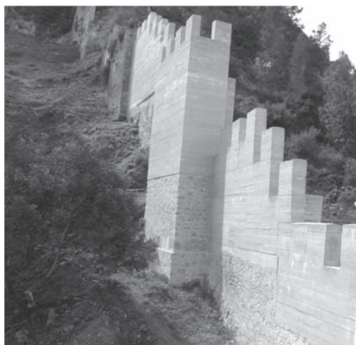
Figura 4. Tramo E11 de las murallas de levante después de la intervención.
