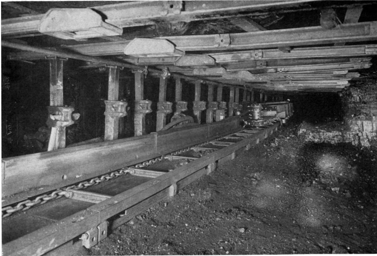
FIG. 16. Armored conveyor with coal cutter mounted. (Maschinenfabrik und Eisengiesserei A. Beien.)
