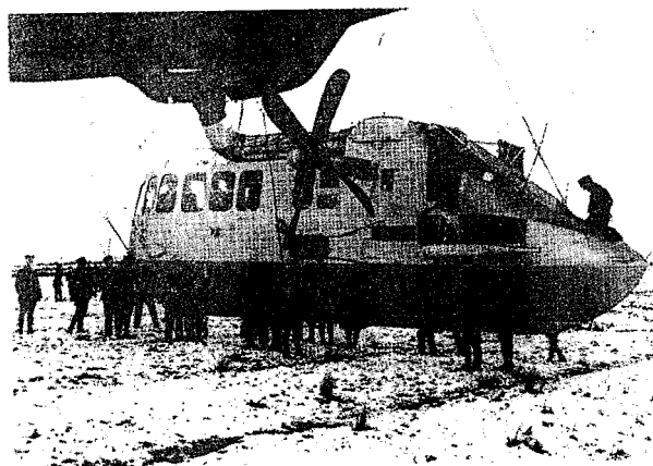
图 11.6 飞艇 No.P6 控制舱展示旋转推进器 (经皇家战争博物馆许可)
